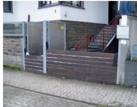
Fig. 9 : Prévention en matière de construction d'un particulier – entrée surélevée et fermeture de la voie d'accès pour les véhicules par des éléments mobiles – Coblenz (FWWV)
