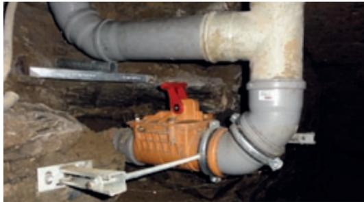
Fig. 7 : Clapet anti-retour installé ultérieurement dans une maison individuelle historique – Leutesdorf sur le Rhin (FWWV)
