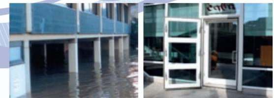
Fig. 6 : a) structure sur pilotis (CIPMS) et b) système de fermeture anti-inondation des portes et des fenêtres résistant à la pression de l'eau, Hamburger HafenCity (FVWW)
