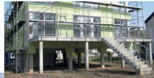
Fig. 4 : Maison d'habitation sur pilotis à Unkel sur le Rhin (FVWW)
