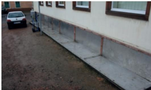
Fig. 8 : Systèmes de fermeture pour les soupiraux (CIPMS)
