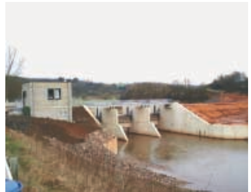
Foto: Arbeitsgemeinschaft HRB Ottweiler
